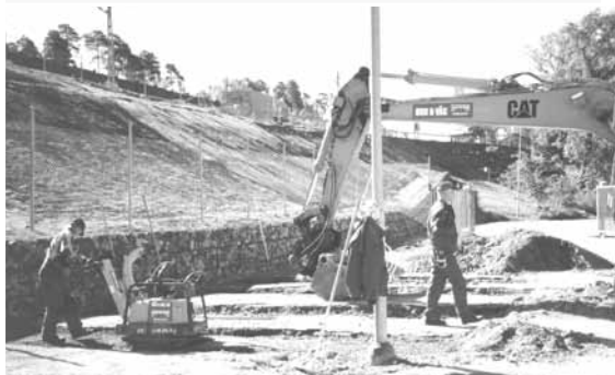
Underlaget för förrådscontainers färdigställs
