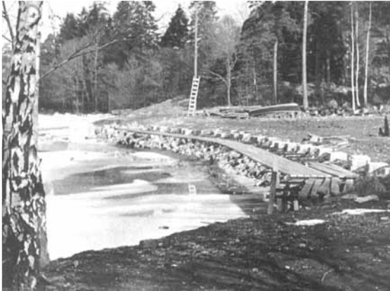
Bryggan mot hamnplanen byggs.
