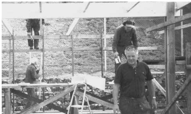
Aulis Karlsson, Rolf Brantlind, Yngve Eriksson och Rolf Lidström lägger tak på förrädscontainrarna. Augusti 2001.
